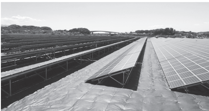
写真2 太陽光発電所での使用例。表と裏の両面で採光して発電できるタイプの発電パネルが主流となっている今日では、地面方向からの採光も重要となっている（写真は“ニードフル防草シート JY-3S”）
